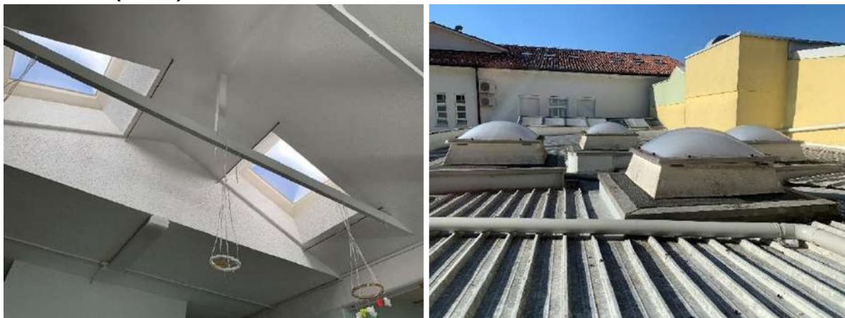
Slika 14: Polikarbonatna streha, rastlinjak novi del (levo), steklena streha, stopnišče telovadnica (desno)
