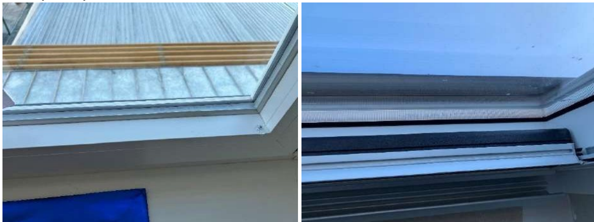
Slika 12: PVC dvoslojno okno, prizidek - 2020 (levo), PVC strešno okno, mansarda novi del – 2021 (desno)
