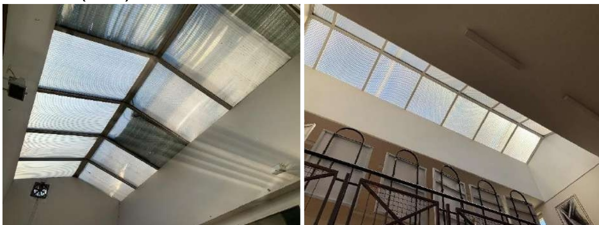
Slika 13: Polikarbonatna streha, rastlinjak novi del (levo), steklena streha, stopnišče telovadnica (desno)
