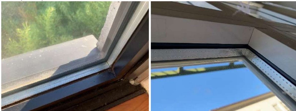
Slika 15: Kovinsko okno z dvojno zasteklitvijo, prizidek - 1983 (levo), ALU okno, novi del – 1996 (desno)
